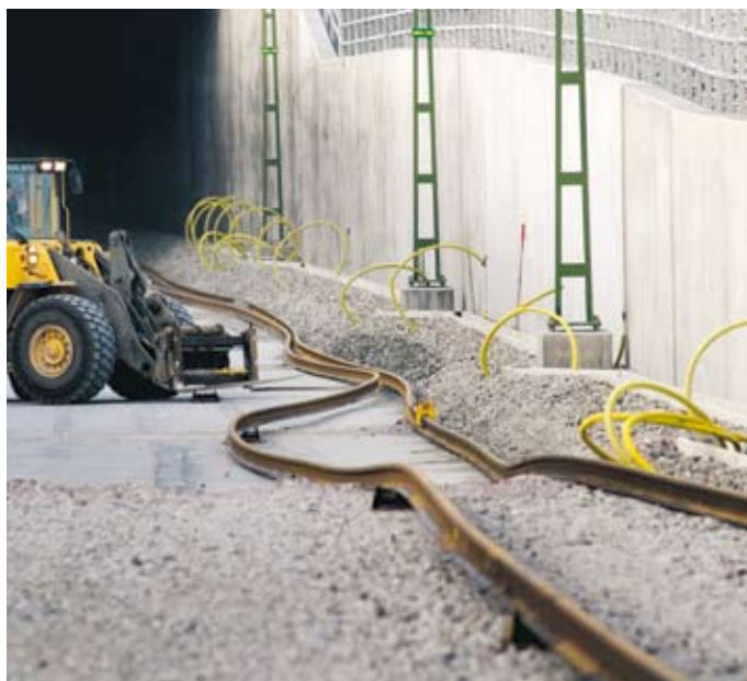
Rälsbitarna är drygt 400 meter långa och förvånansvärt böjliga.
